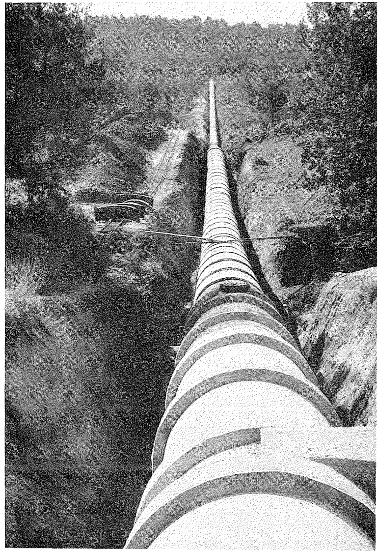
→ Siphon du Tholonet. Longueur totale 800 m. Vue de la partie aval. Au premier plan, les couvre-joints et le massif de butée. Après le trou d'homme, les couvre-joints ne sont pas faits. Cliché S.A.D.E.
